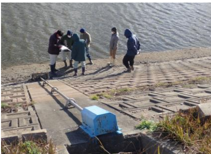
堤防前面劣化調査
