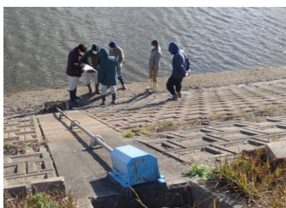
堤防前面劣化調査
