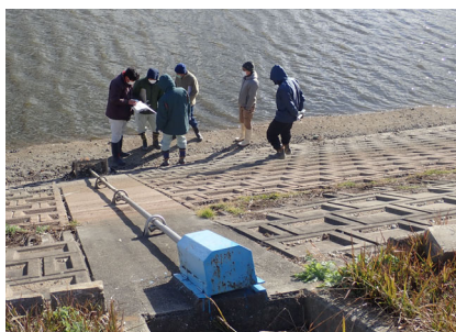
堤防前面劣化調査
