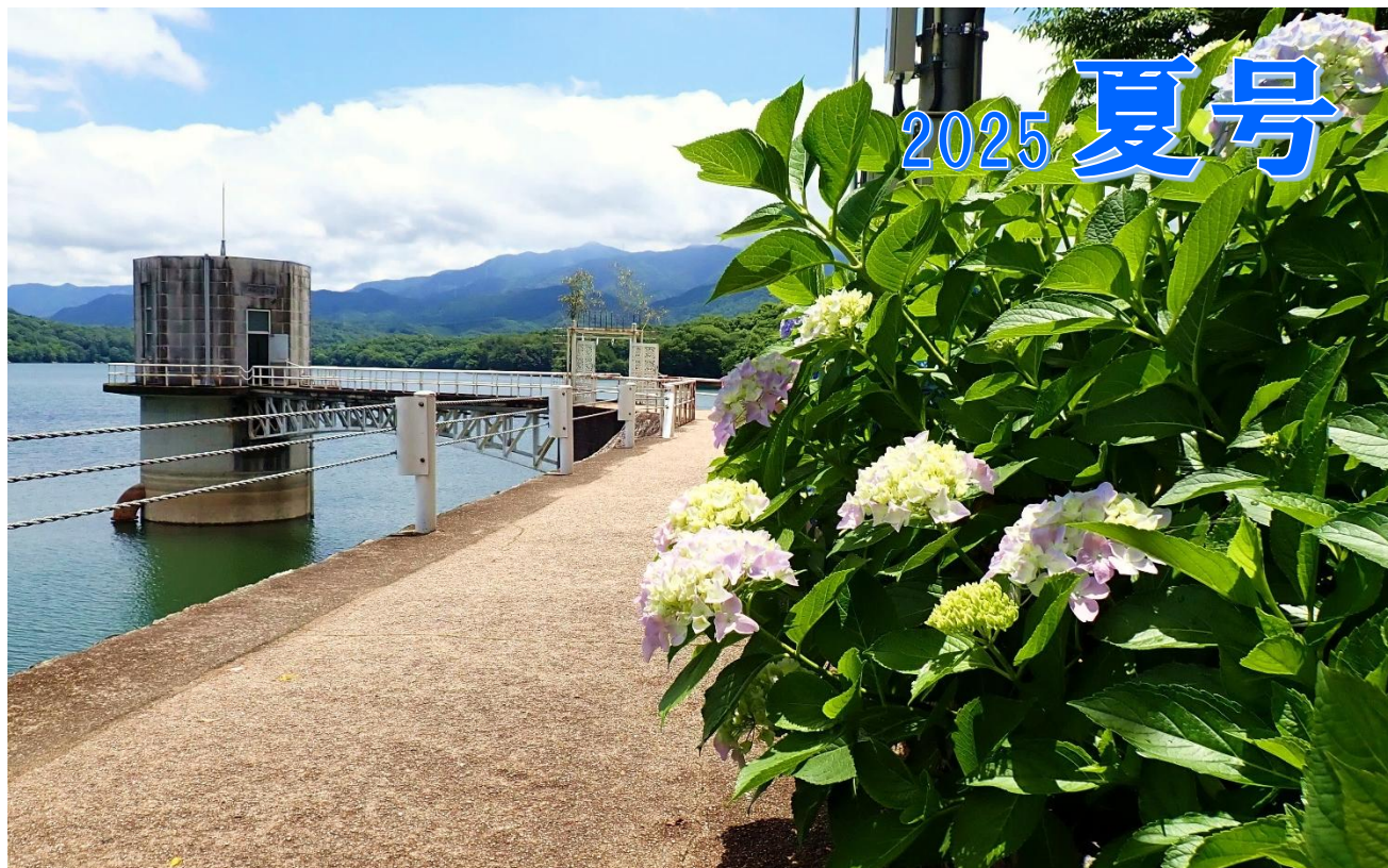
満濃池の取水塔（仲多度郡まんのう町）
