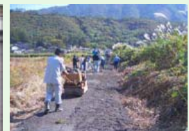
砂利舗装をアスファルト舗装へ
