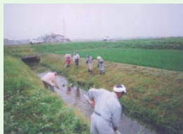
水路の泥上げ (日常の管理)
