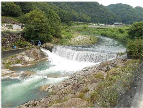
地下清頭首工
